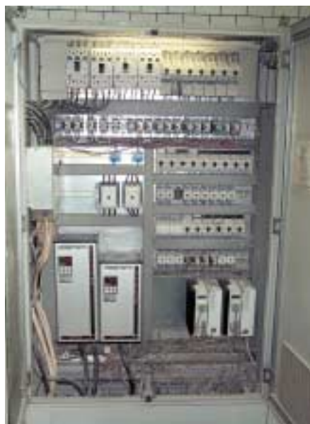
Рис. 4. Силовая секция шкафа управления
